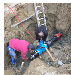
Ersatz der Hauptwasserleitung
