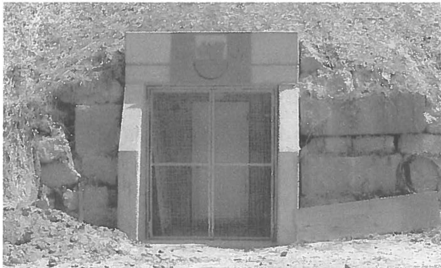
Eingang zum neuen Wasserreservoir im Rainwald
