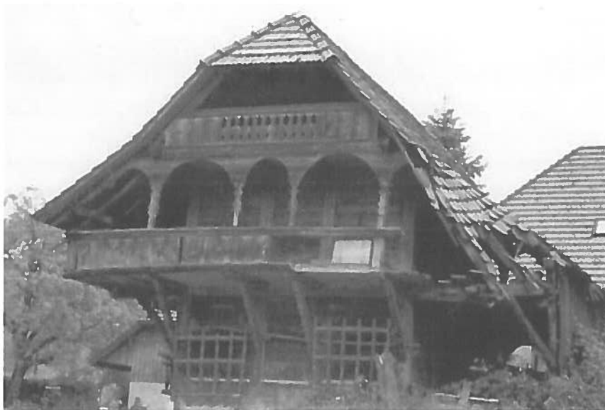
Der Spycher vor der Sanierung
