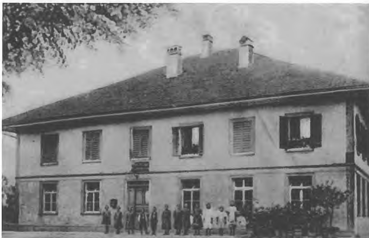
Das zwischen 1846 und 1848 erbaute Schulhaus um 1920 herum
