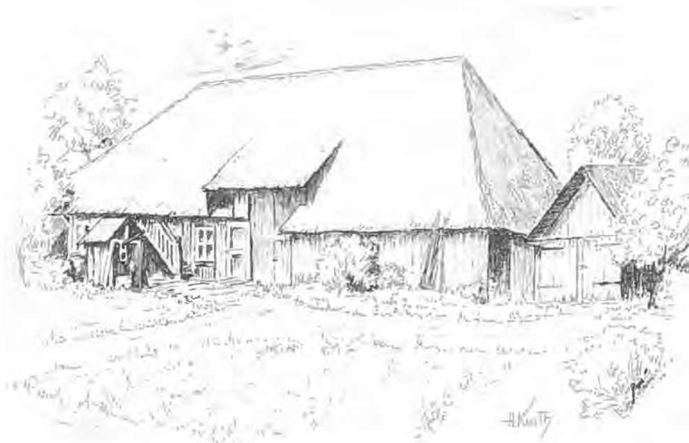
Hier wohnte Emil Sohm, genannt „Miuer“ Das Haus im Flösch wurde 1998 abgebrochen
