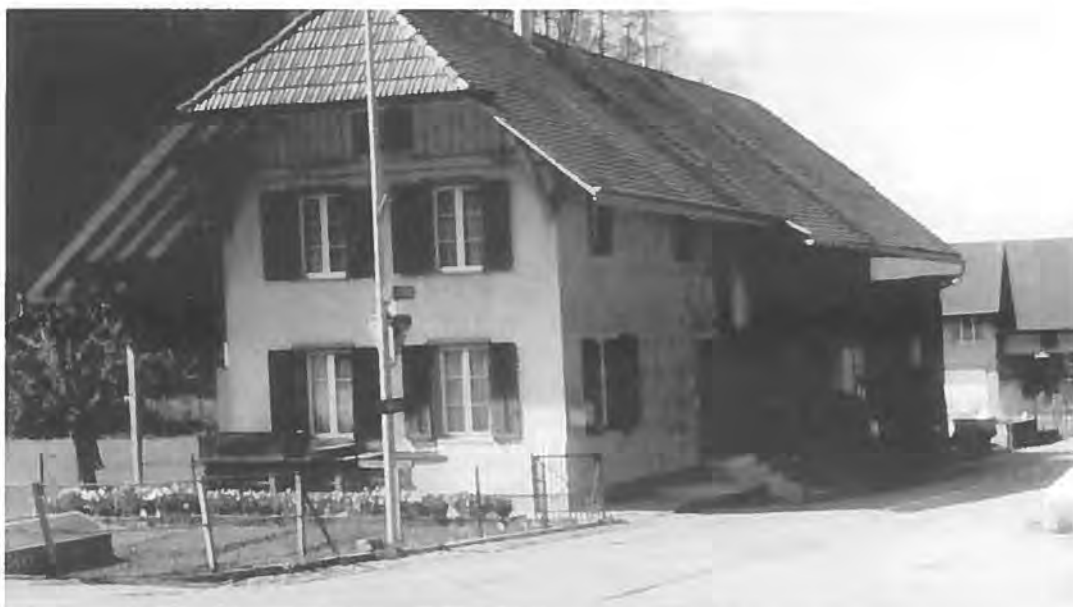
Ansicht des Hauses in Thörigen heute (Strassenseite)
