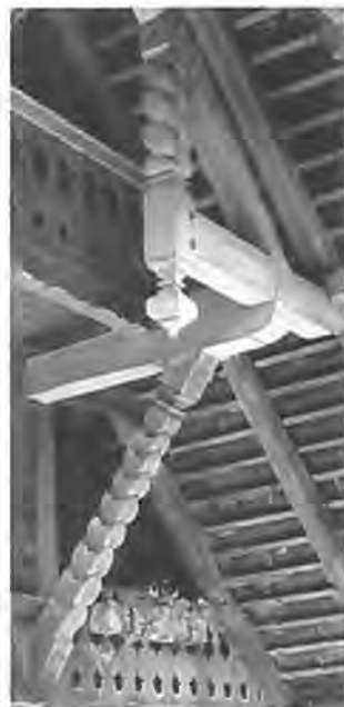
Dachstuhl-Partie von „Reses“ Haus im Wil, erbaut 1832, in dem es zeitweise eine Wirtschaft gab
