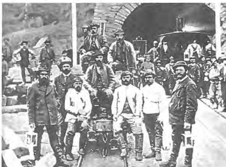
Bautrupps vor dem Durchstich des Gotthardtunnels
