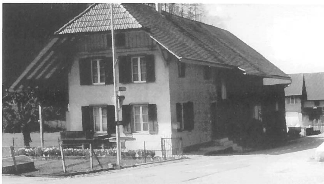
Ansicht des Hauses in Thörigen heute (Strassenseite)
