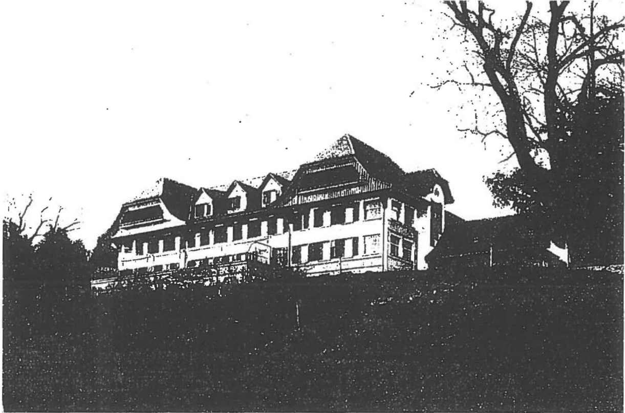
Kantonales bernisches Kindersanatorium „Maison blanche“ in Leubringen
