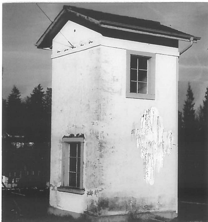
Das frühere Transformatorenhäuschen
